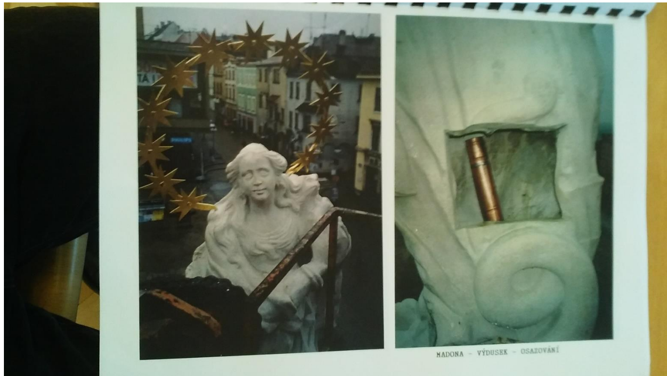
Umístění měděného tubusu s pamětními dokumenty do dutiny sochy. (fotografie z restaurátorské zprávy z roku 1996)
